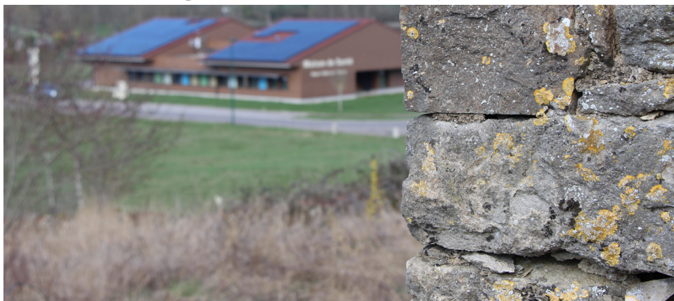
Centrale photovoltaïque installée sur le toit de la maison de santé de Bligny-sur-Ouche
